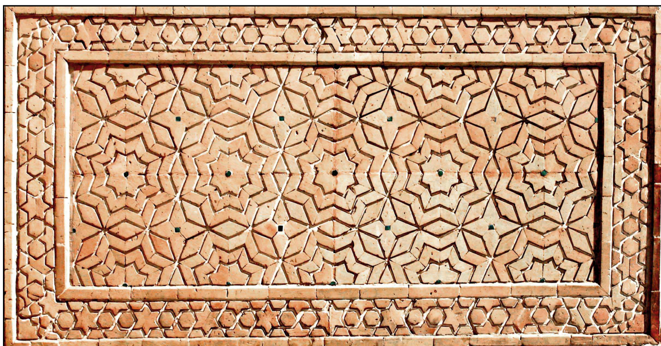
Au dessus, parement de marbre incrusté d'entrelacs de néphrite de la médersa d'Oulough Begh au Registan. Au dessous, briques cuites ciselées de la mosquée Kalon à Boukhara.
