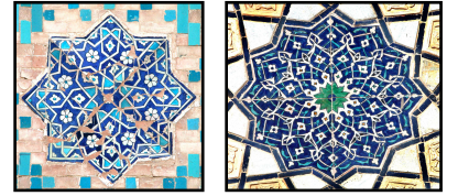
Mosquée Tilla Kari du Registan : motifs de majoliques incrustés dans l'appareil de briques et de kaschis.
