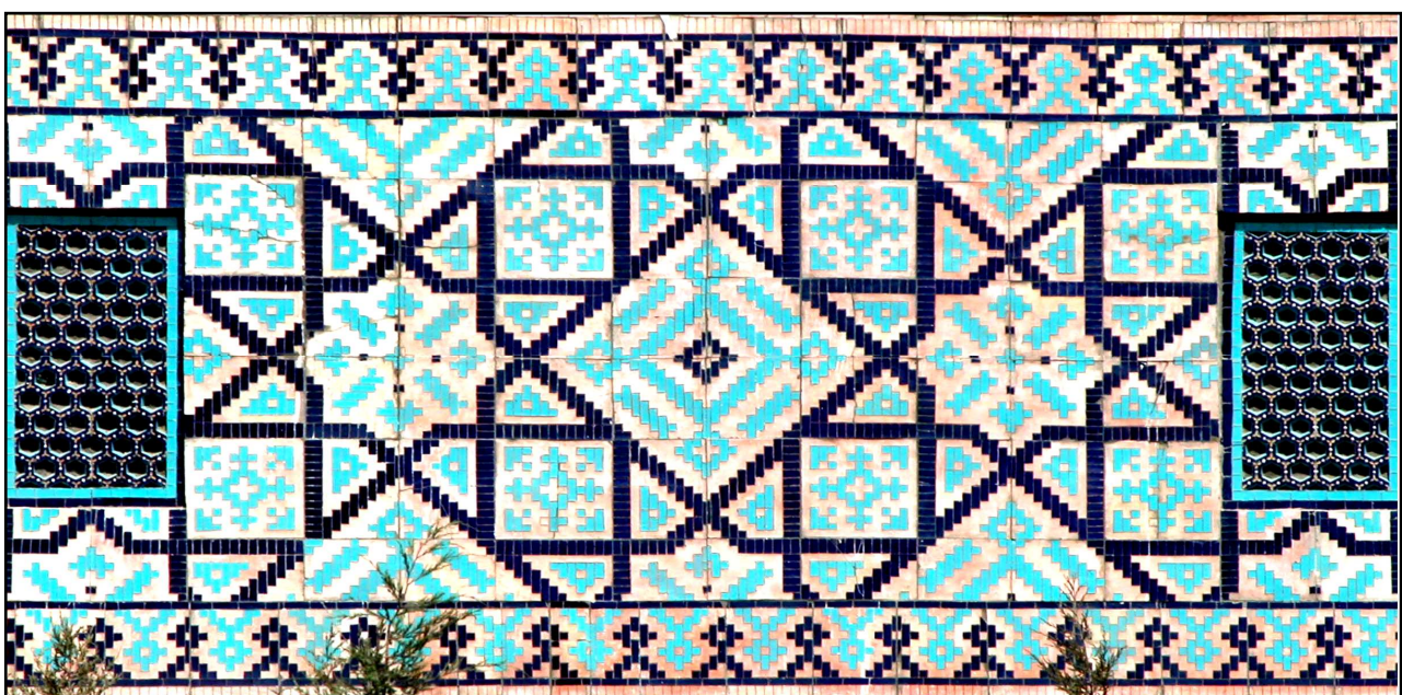
Mur d'enceinte du Registan à Samarcande formé de giriks.
