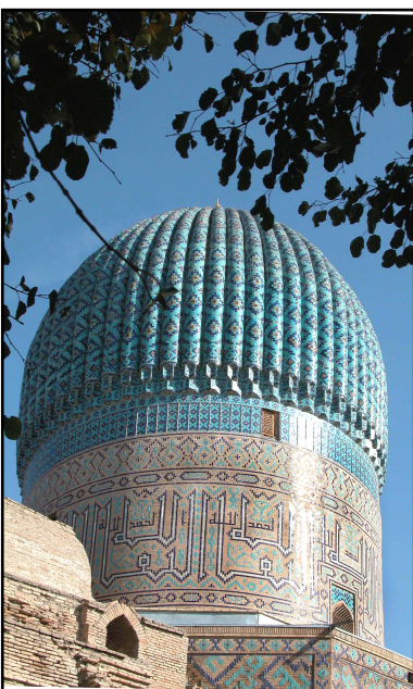
Dôme sur tambour du Gour Emir.
