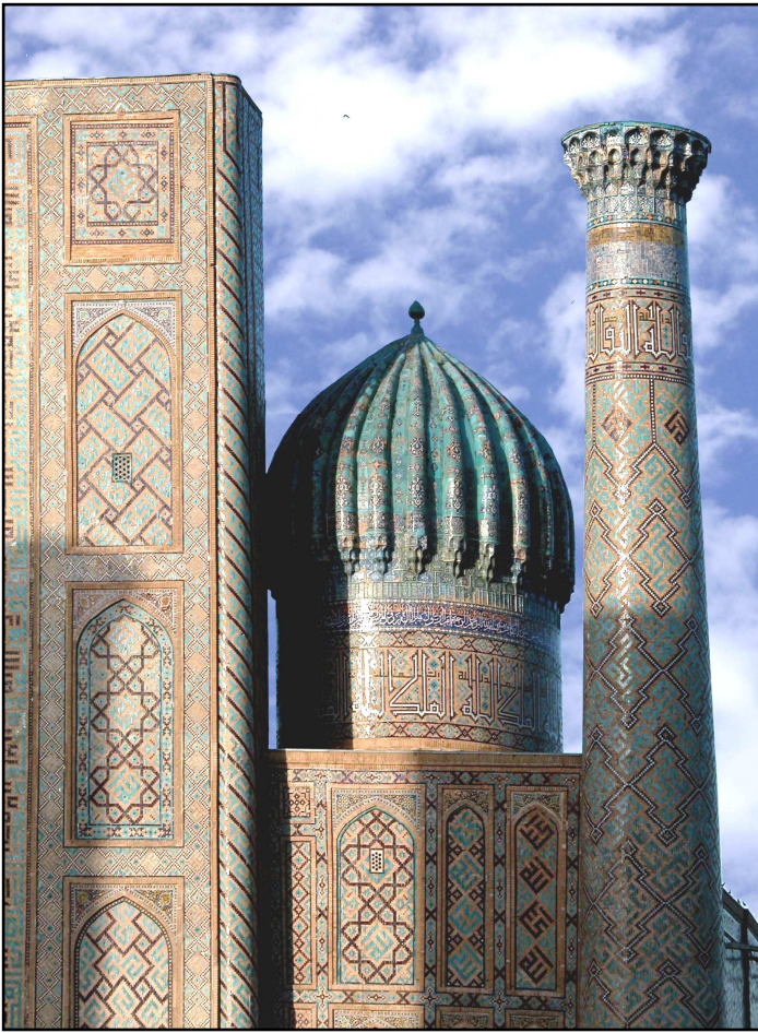
Dôme renforcé par des côtes de la médessa Chir Dor de Samarcande.
