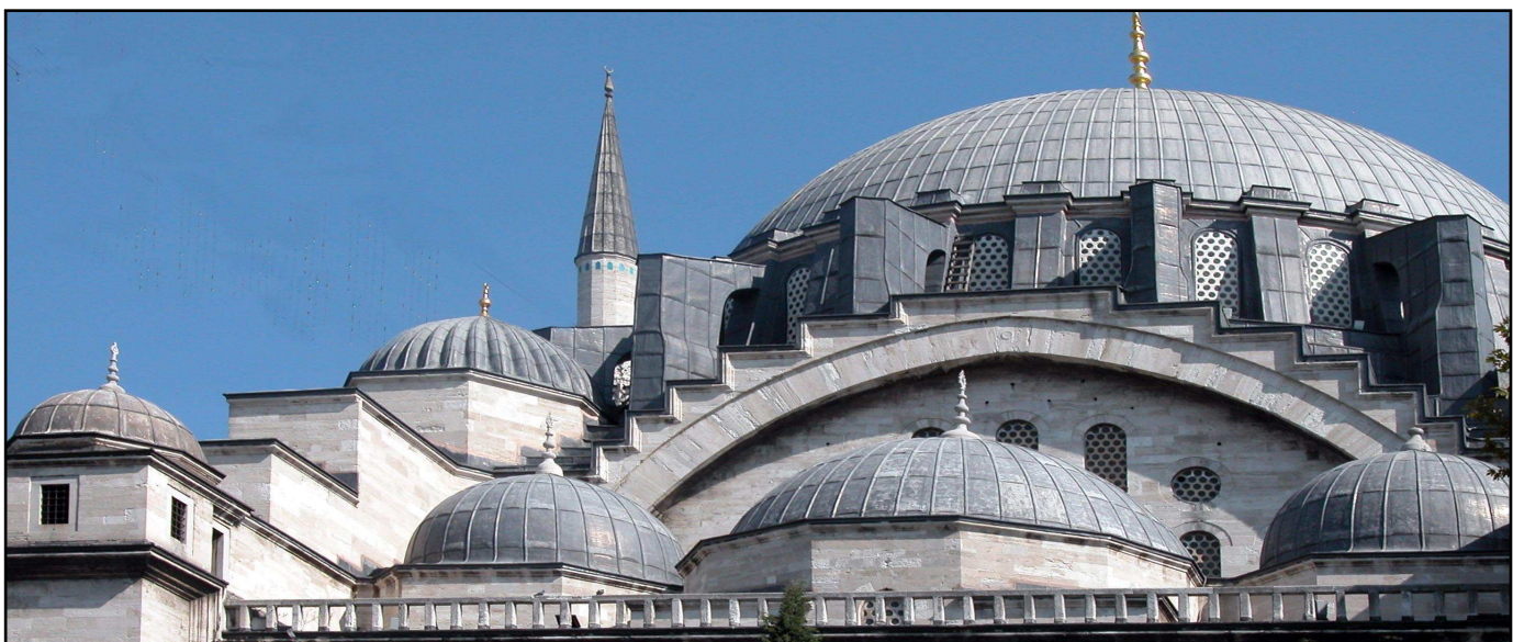
Dôme et demi-coupoles de contreforts de la Süleymaniye construite par Sinan en 1550.
