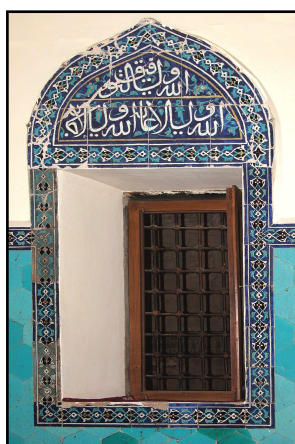
Bursa : faux arc de la Mosquée Verte.
