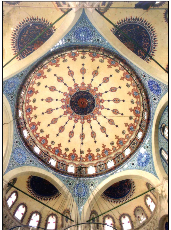
Mosquée Sokollu Mehmet Pacha construite par Sinan en 1571 : la coupole est soutenue par six arcs en plein cintre.
