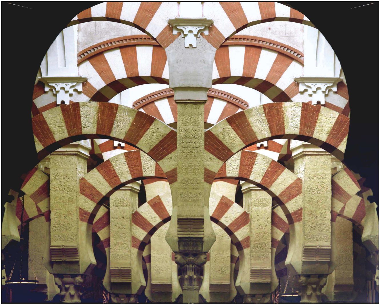
Forêt de voûtes plein cintre outrepassées s'équilibrant les unes par rapport aux autres à la Mosquée de Cordoue.
